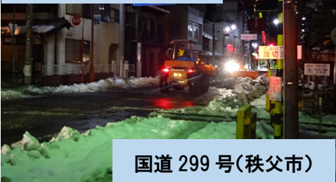
除雪(夜間作業)
