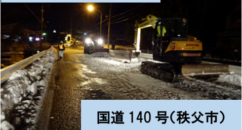
除雪(夜間通行止め)
