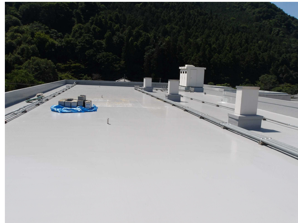
屋上：防水工事中
